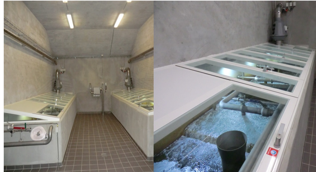
Bundbeluftning Ribe vandværk
